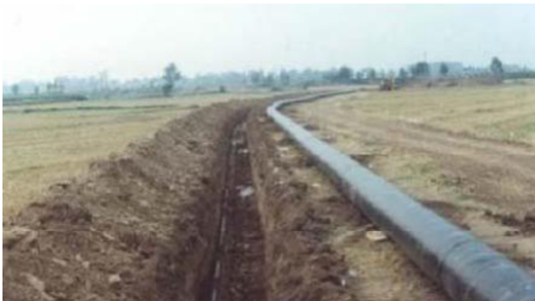
图 3.2.1-14 国内同类工程管线开挖实景图片
